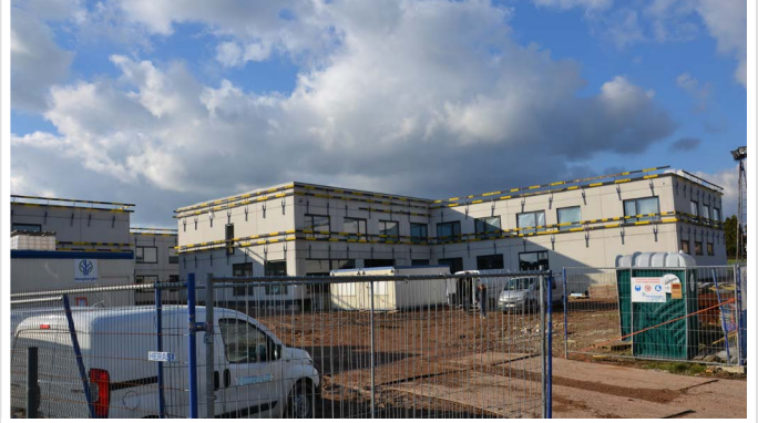
Het nieuwe woonzorgcentrum zal openen in september
